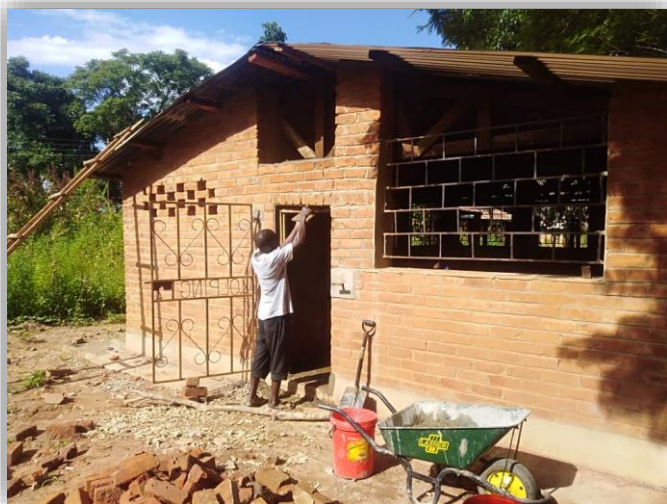
Renovierung des Schweinestalls
