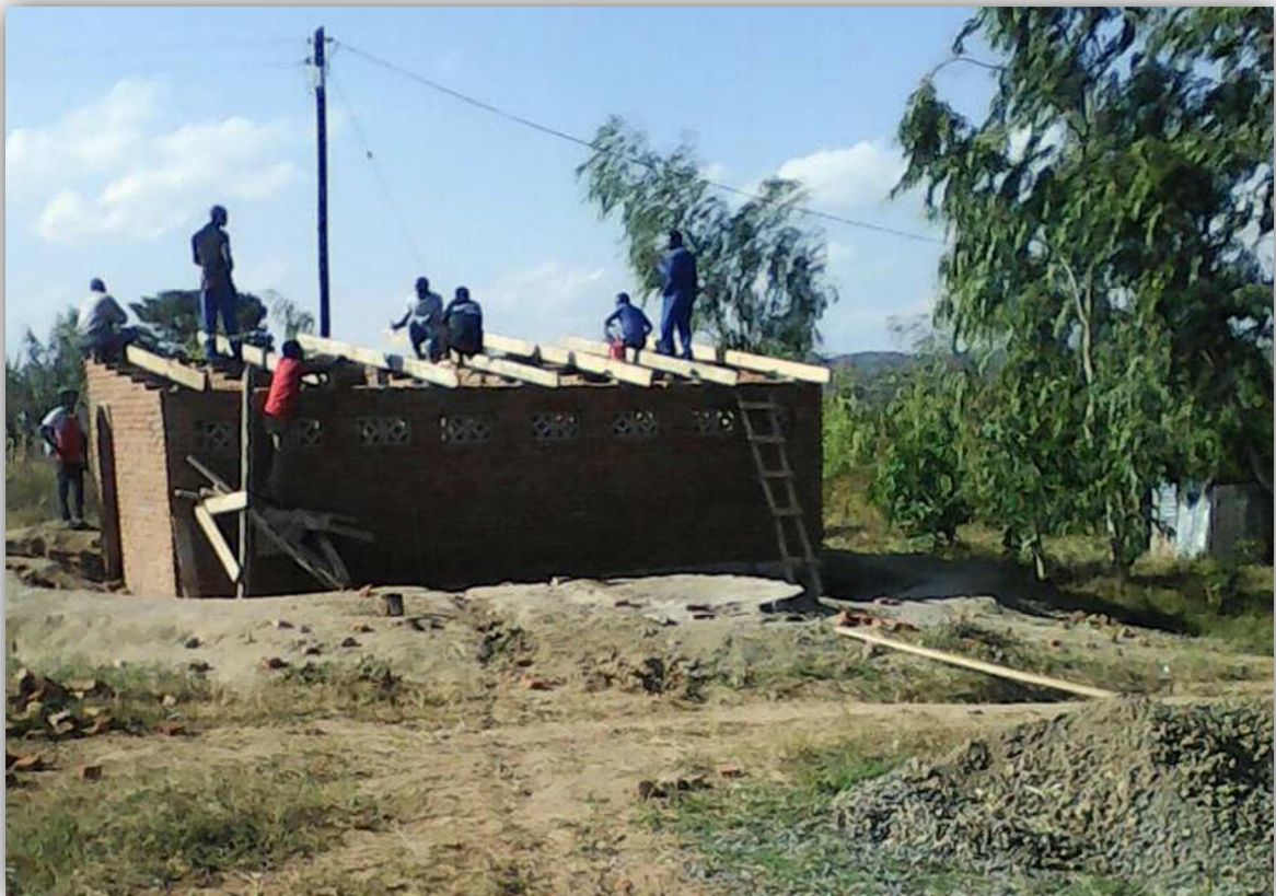
Beim Bau der Toiletten
